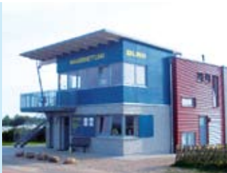
Ein großer Dienstraum, Unterkünfte für zwölf Rettungsschwimmer und Materiallager befinden sich in der neuen Wache in Hasselberg.
